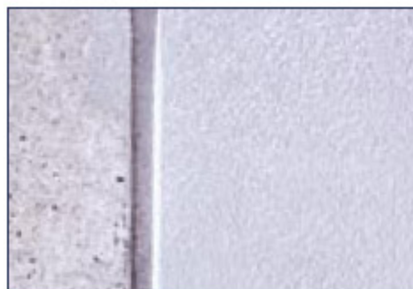
Vorher Nachher Beschichtete Fläche mit Kopfrollung und Fugenverguss
